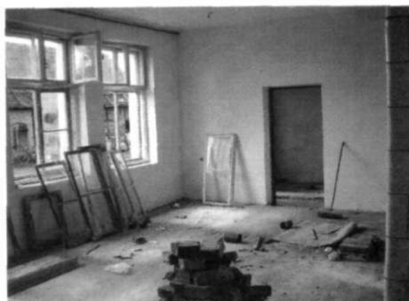
Świetlica w trakcie remontu
