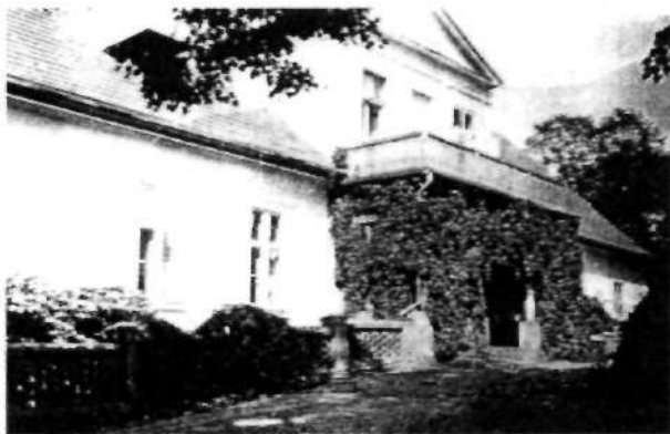
Gutshaus Grunau – Vorderseite
