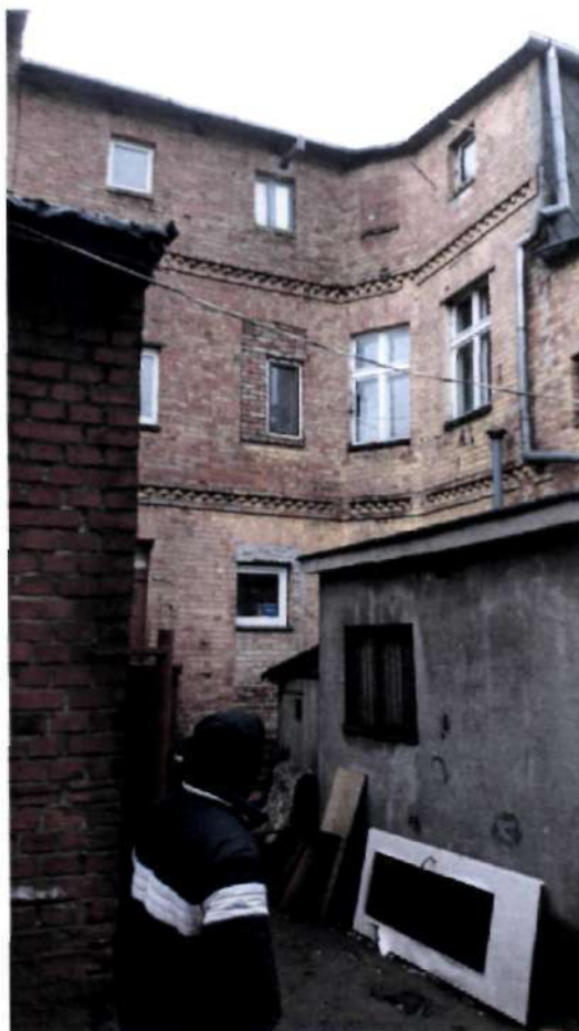
Rysunek 43. Budynek wspólnoty mieszkaniowej przy ul. Traugutta (widok oficyny od ul. Barlickiego)
