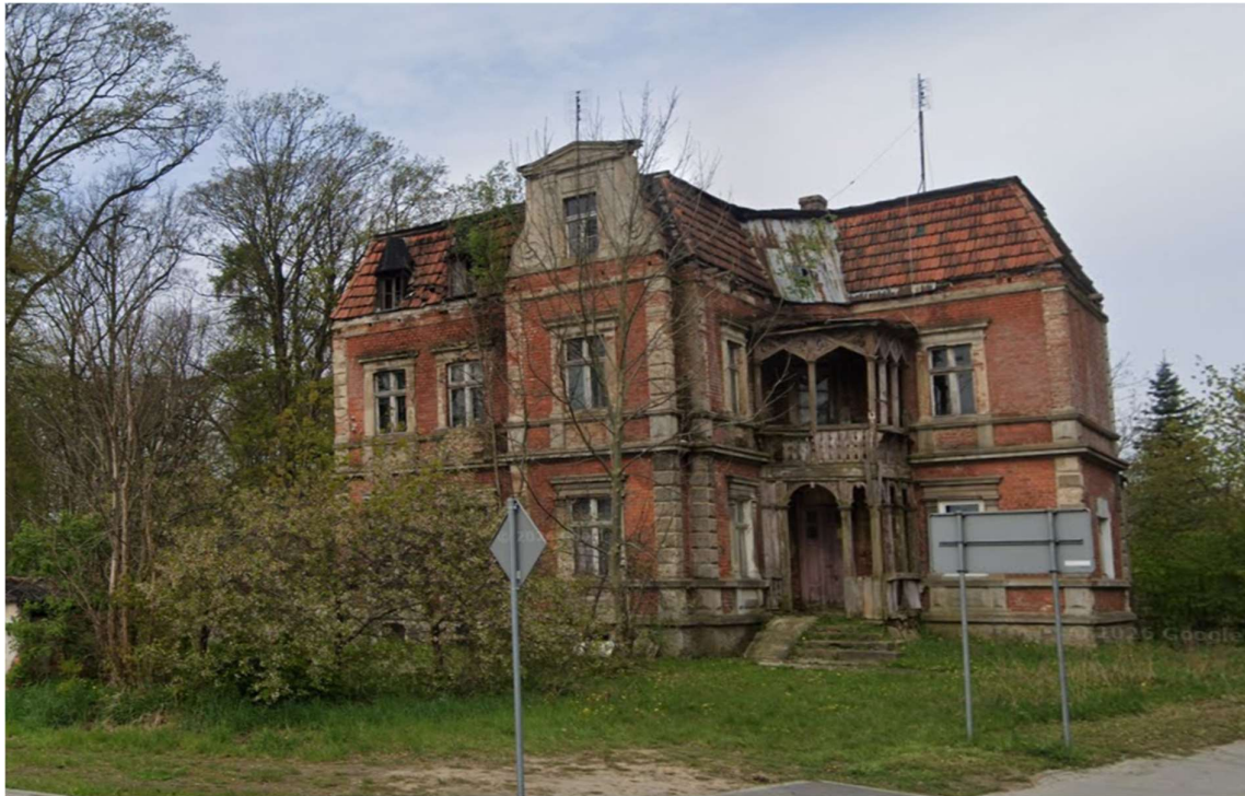
Widok terenu od strony wschodniej
