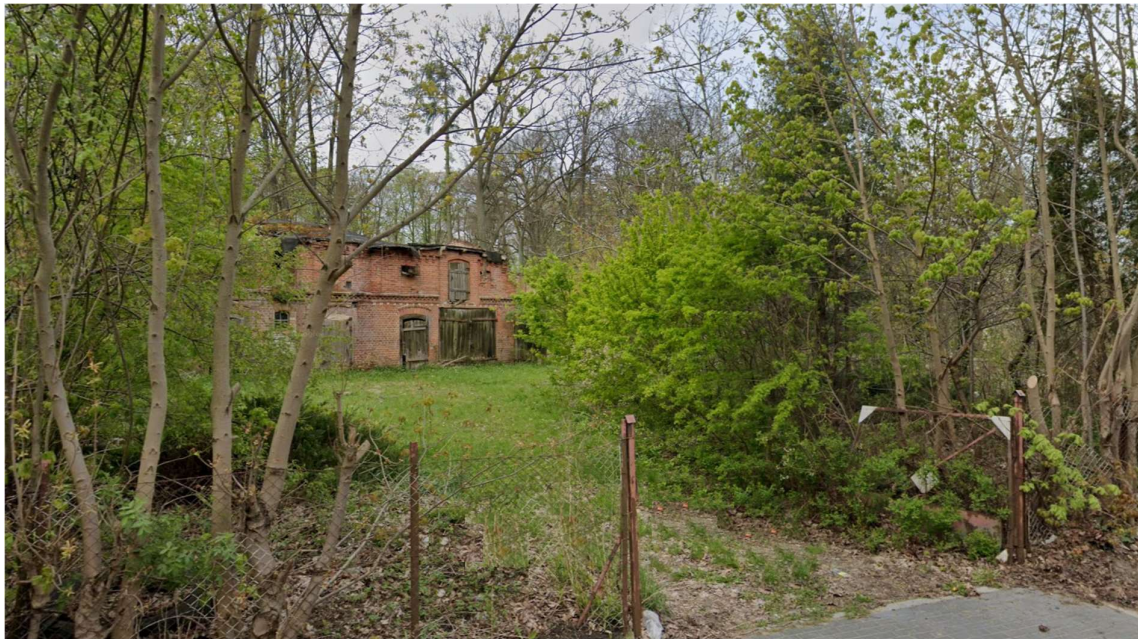
Zaniedbany ogród widziany od ul. Królewieckiej
