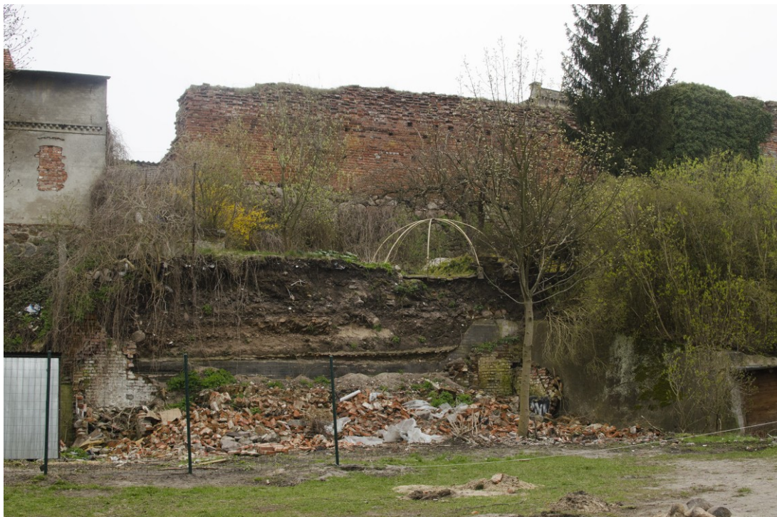
Rysunek 45. Obsuwające się skarpy pod murami obronnymi - ul. Długa.
