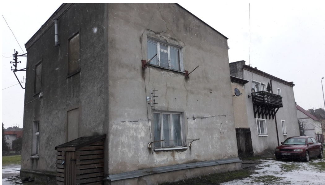
Rysunek 44. Zaniedbany budynek mieszkalny przy ul. Barlickiego
