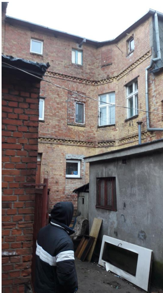
Rysunek 44. Budynek wspólnoty mieszkaniowej przy ul. Traugutta (widok oficyny od ul. Barlickiego)
