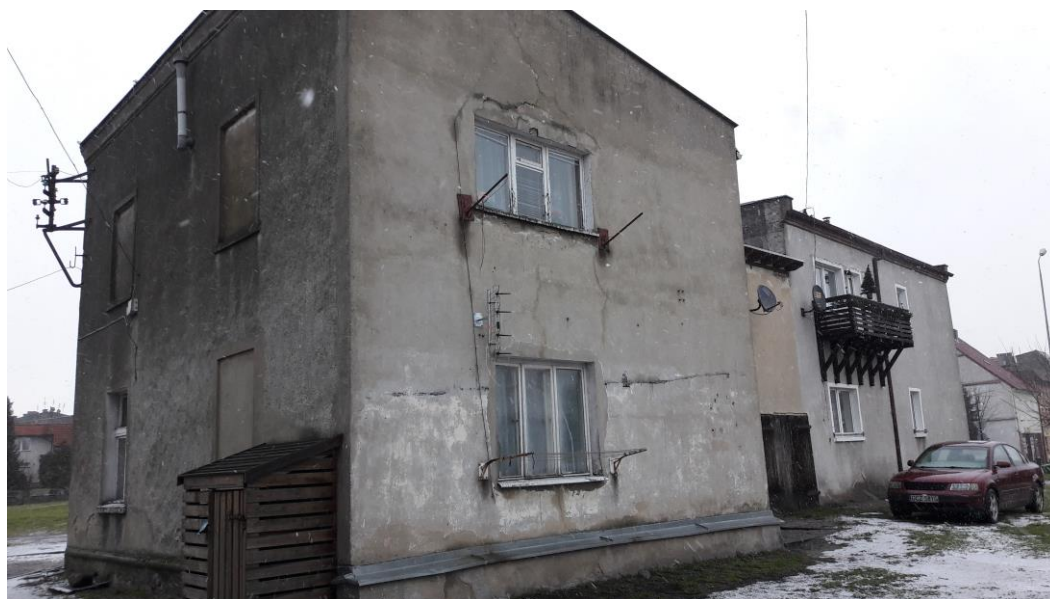
Rysunek 45. Zaniedbany budynek mieszkalny przy ul. Barlickiego
