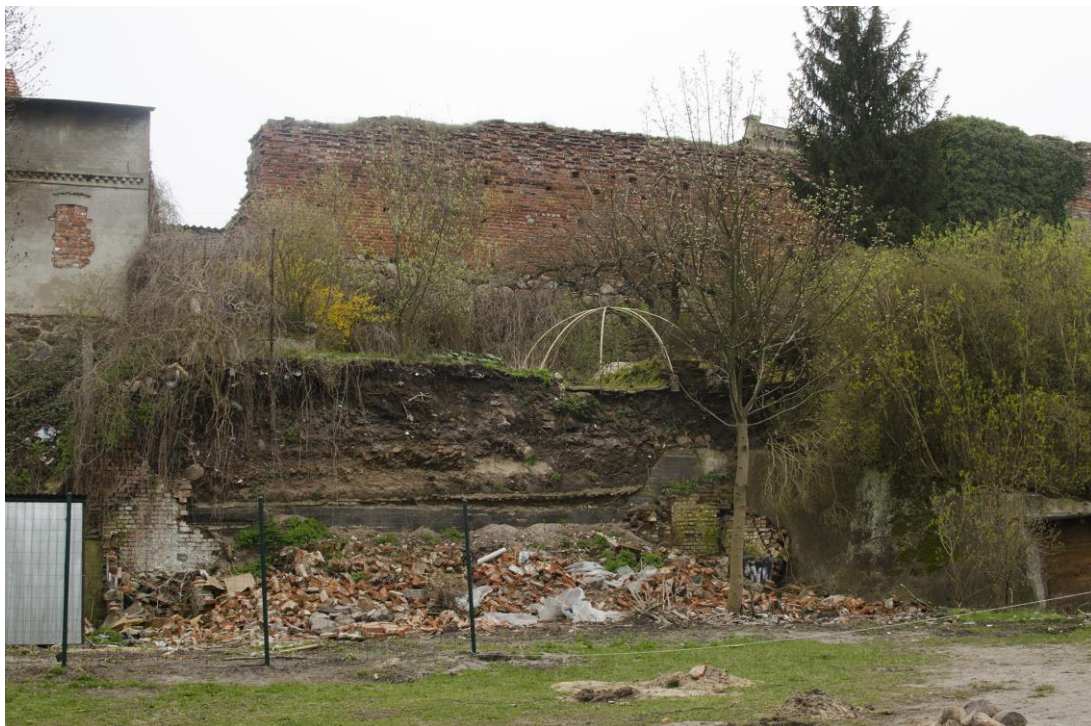
Rysunek 46. Obsuwające się skarpy pod murami obronnymi - ul. Długa.
