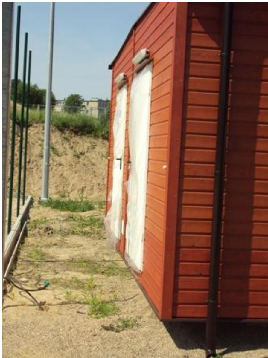
18. Miejsce na wbudowanie schodów.
