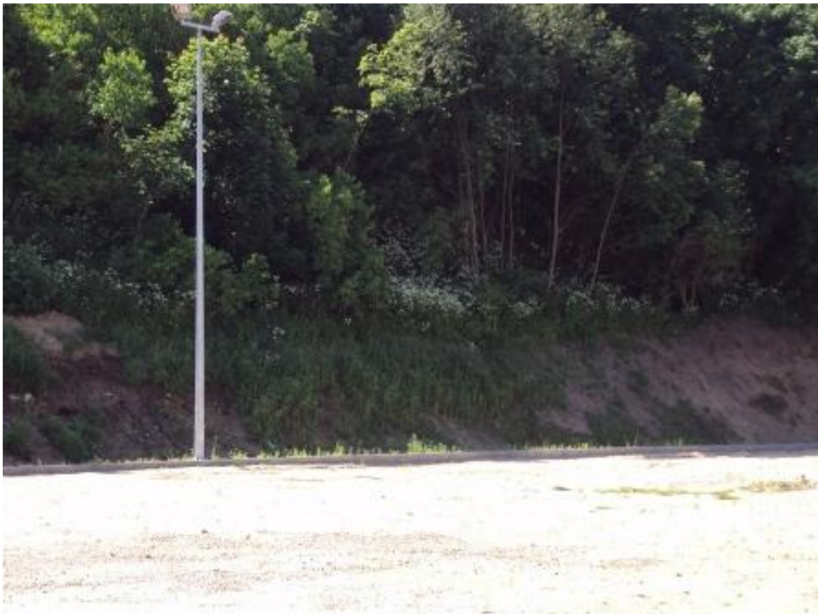
3. Boisk do gry w piłkę nożną wraz z skarpą do zabezpieczenia.
