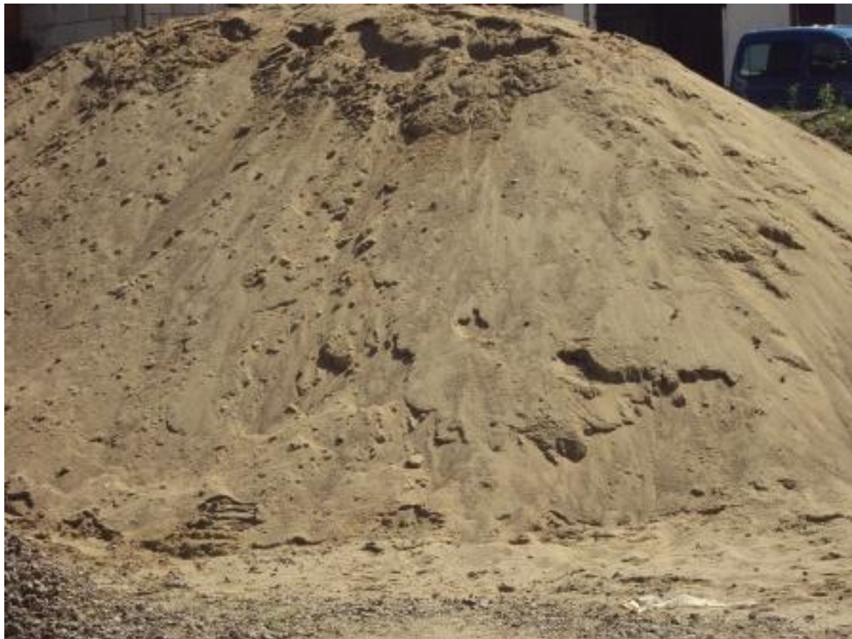
7. Hałda piasku do wbudowania przez Wykonawcę.
