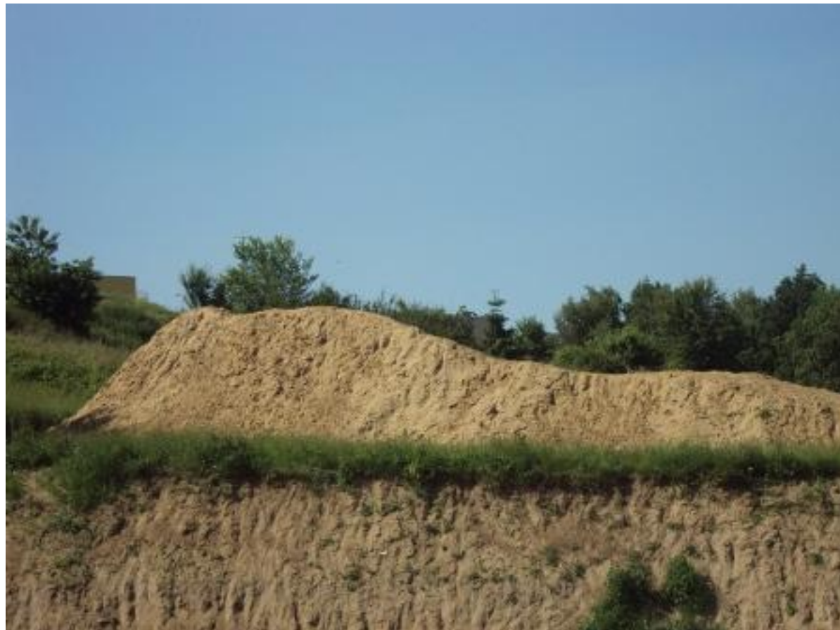
5. Hałda ziemi gruntu z przeznaczeniem do wywozu przez Zamwiającego.
