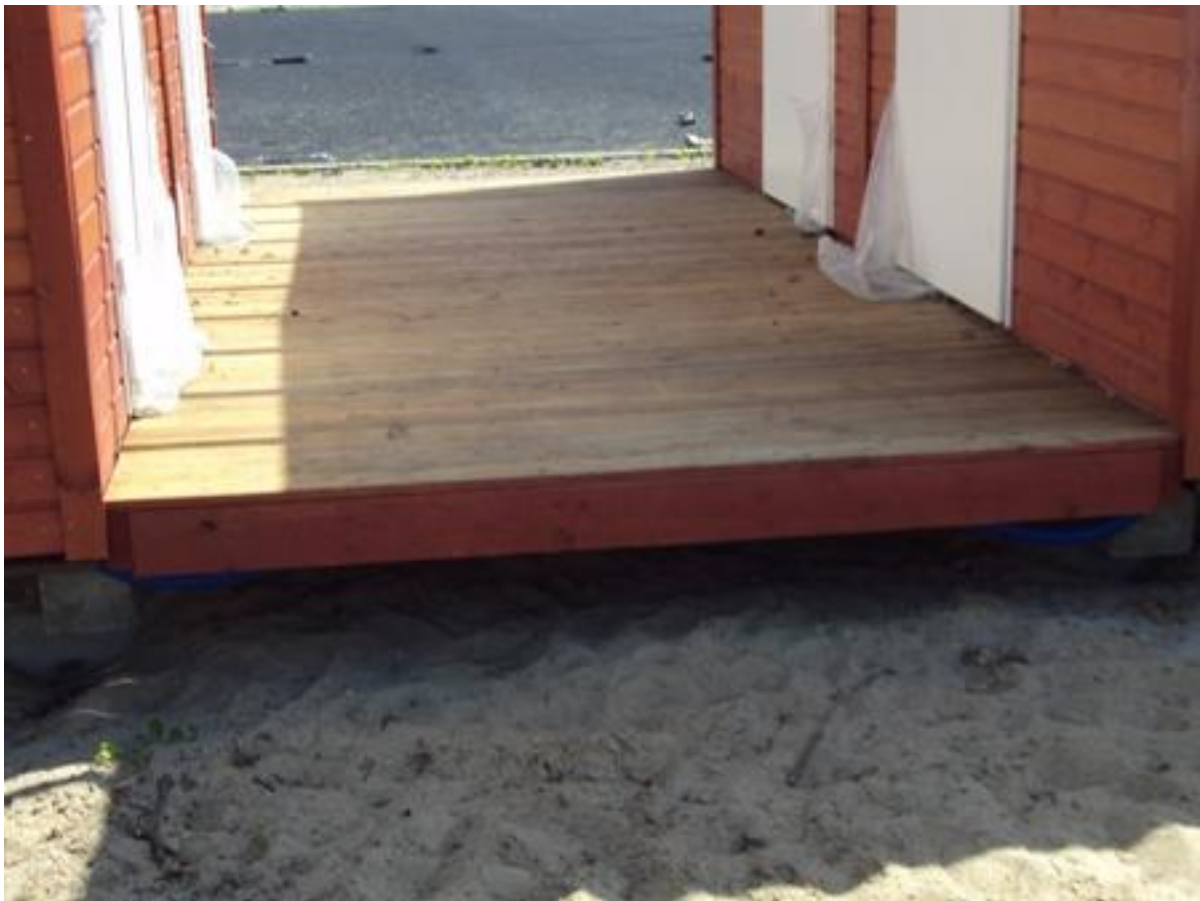
19. Posadowienie budynku zaplecza.
