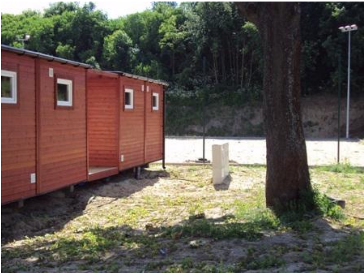
19. Widok zaplecza od tyłu – schody wejściowe do zrobienia.
